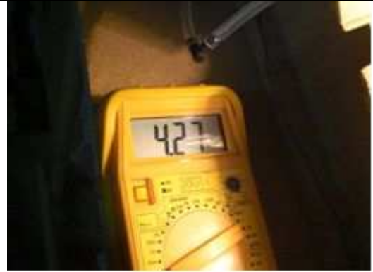
Medición con el polímetro, de la energía eléctrica real proporcionada por el sistema convencional. 4,27 V.
