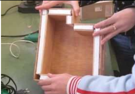
Colocación de paredes con material aislante en la planta primera de la "vivienda sostenible".
