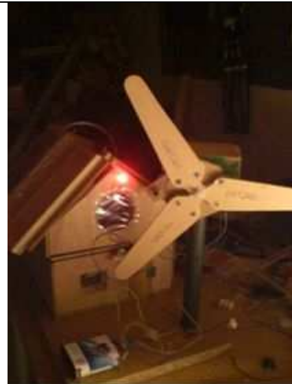
Vista general en funcionamiento del sistema híbrido de generación de energía eléctrica.
