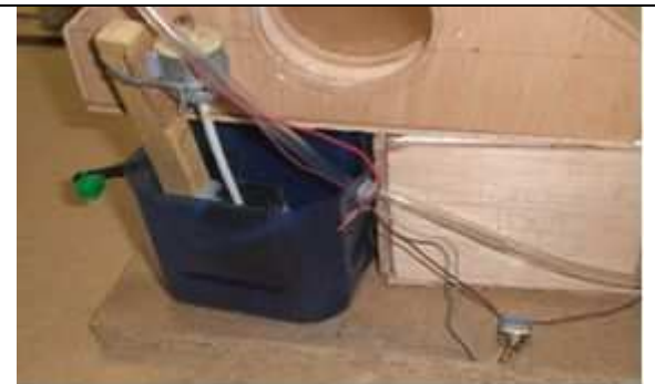
Depósito acumulador de calor, bomba de agua (no comercial), y tubos de plástico empleados en las conducciones.
